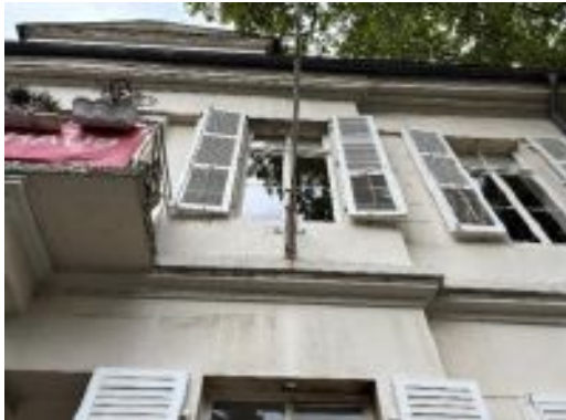
Holzrahmen-Fenster (1-fach-Verglasung) – Am Kurpark
