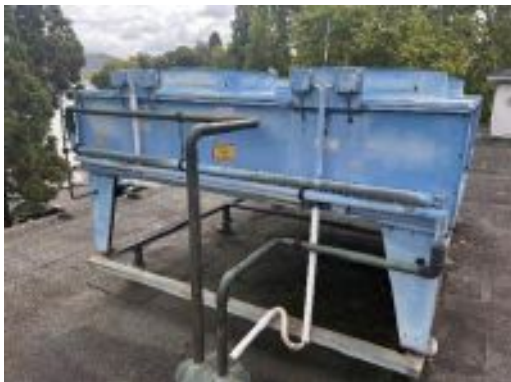
Rückkühler – Dachfläche/Dach
