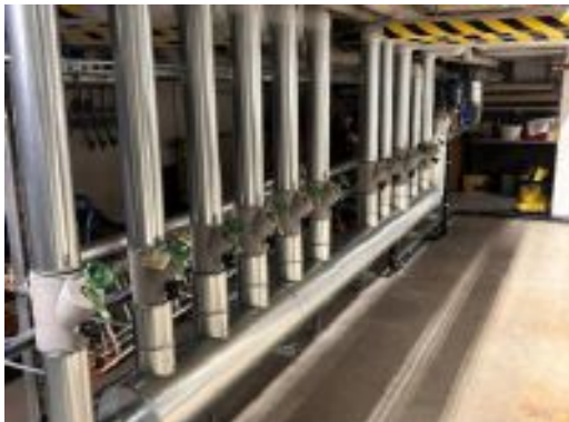
TW-Verteiler – Technikzentrale/2.UG
