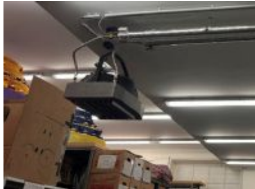
Neue Umluftdeckenheizgeräte
