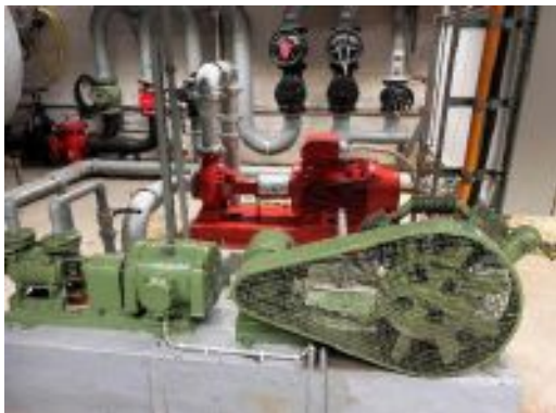
Löschwasserpumpen – Technikzentrale/UG
