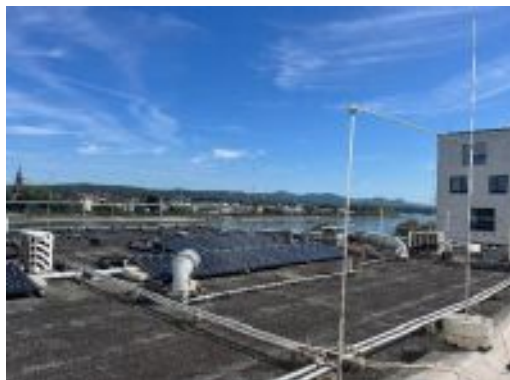
Bitumendachfläche Bauteil D
