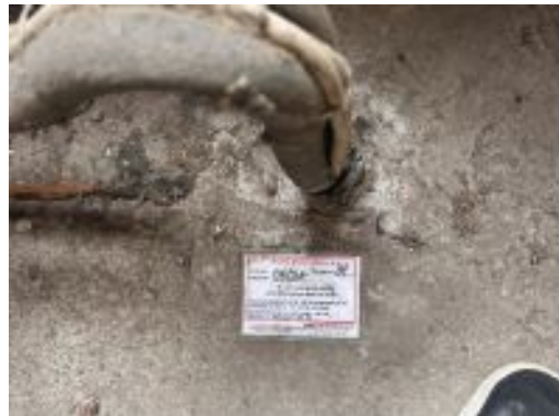
Deckendurchführung – Kesselhaus/OG
