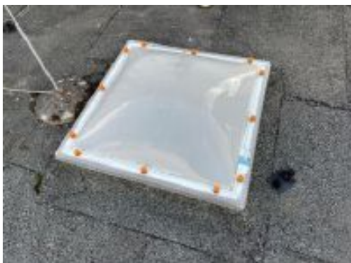
Lichtkuppel Bitumenflachdach
