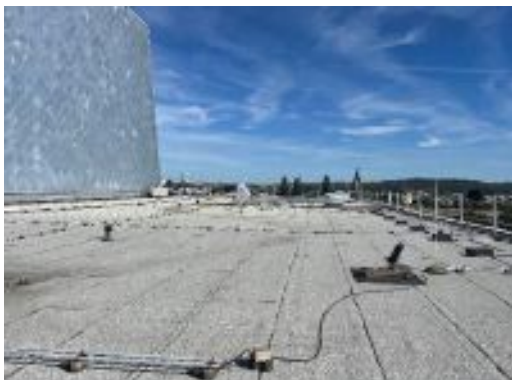
Bitumendachfläche Bauteil B
