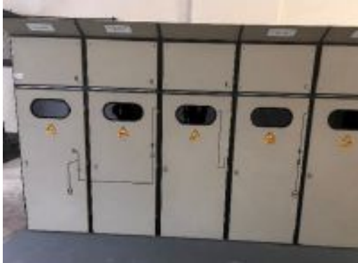
MS-Schaltanlage – Kesselhaus/1.OG
