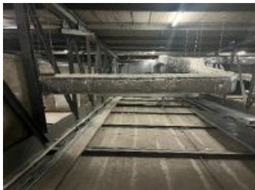
Stahltragwerk – unterhalb Dachebene
