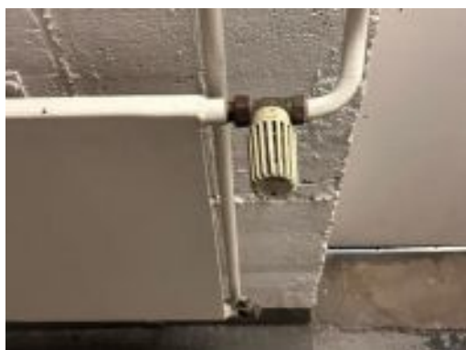
Plattenheizkörper - Flure
