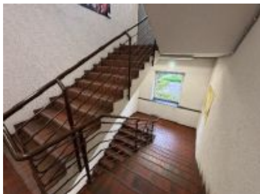
Exemplarisches Treppenraum Gebäude 10
