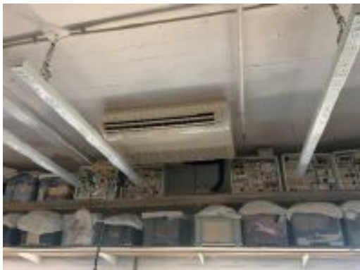
Umluftkühlgerät – Schneiderei/3.OG
