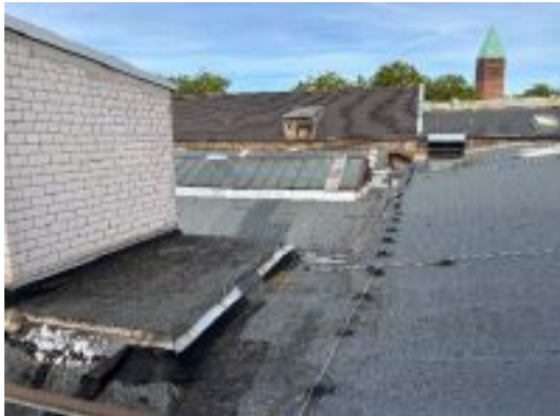
Dachaufsicht Gebäude 8, 19 und 20
