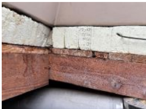
Unterkonstruktion und Dämmung - SSH
