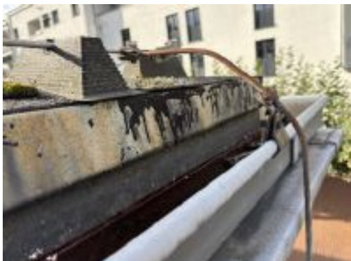
Blitzschutz Bitumenflachdach
