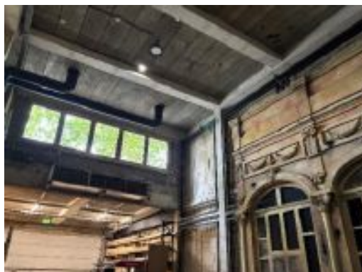
Stahlbeton-Unterzüge – Kulissenlager
