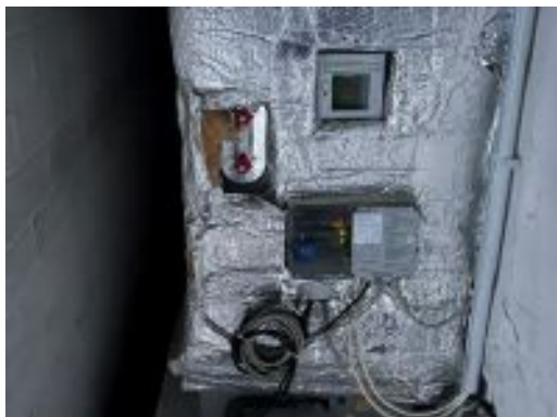
BSK-Steuerung – Lüftungszentrale/DG
