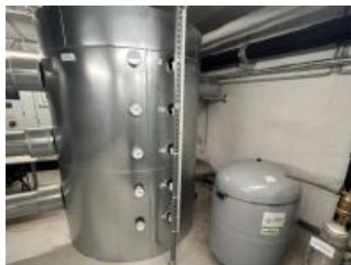
Pufferspeicher – Kältezentrale/UG
