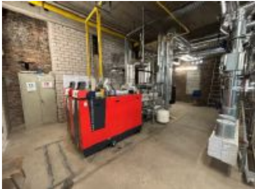
Gas-Brennwertkessel BJ.2020
