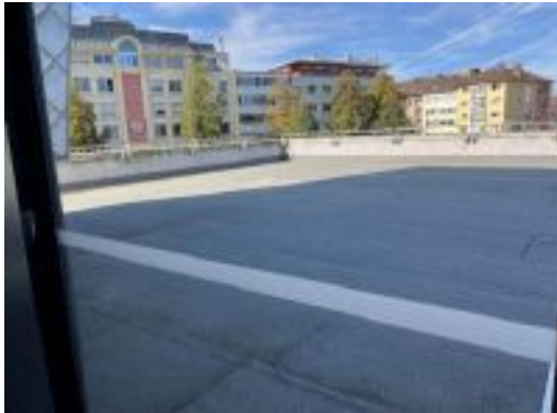
Bitumendachfläche oberhalb Foyer
