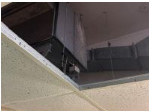
Lüftung Foyer –Zwischendecke/EG
