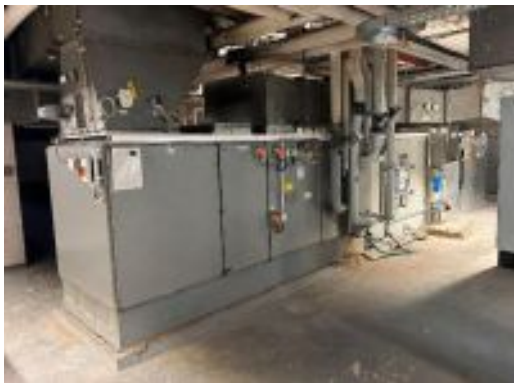
Zuluftgerät – RLT-Zentrale/UG
