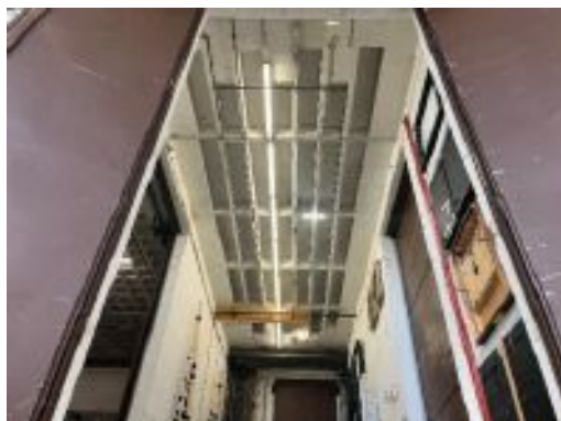
Stahlbetonkassettendecke
