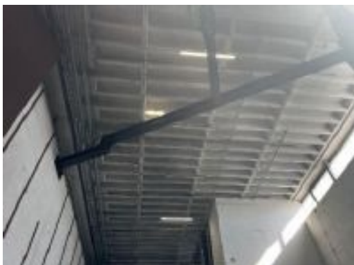
Stahlbetonkassettendecke
