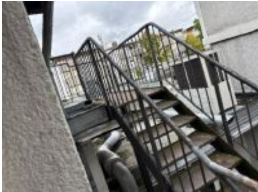
Fluchttreppe an der Ostseite – SSH
