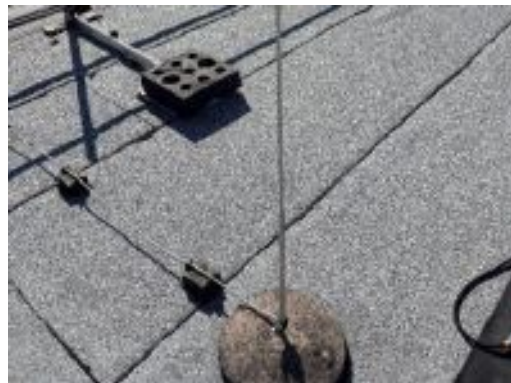
Blitzschutzanlage – Dach
