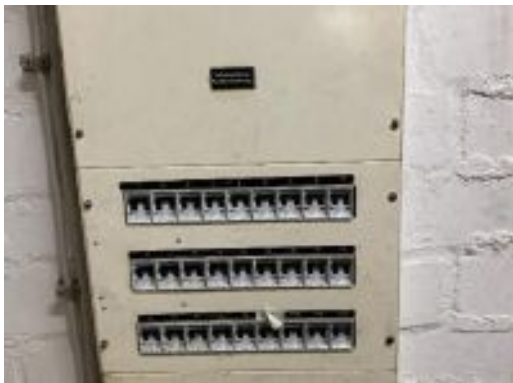
Sicherheitsbeleuchtungsverteilung – 1.UG
