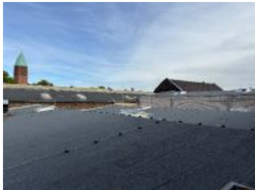
Dachaufsicht Gebäude 18, 19 und 21
