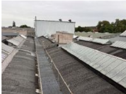
Dachaufsicht Gebäude 8 und 9
