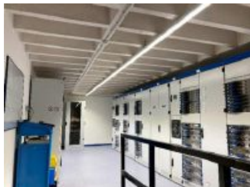
Niederspannungshauptverteilung – NSHV/B.009
