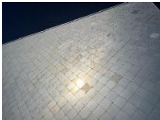
Aluminiumkassettenblech-Verkleidung
