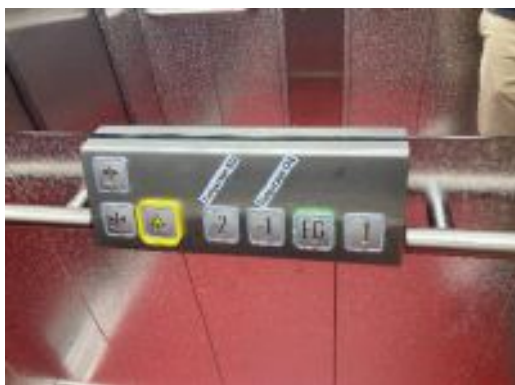
Barrierefrei Sanierter Aufzug – Kassenhalle
