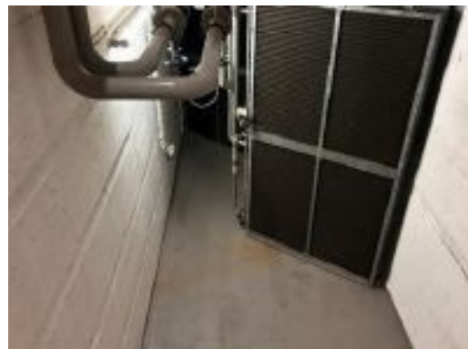
WRG-Register – Lüftungszentrale/UG
