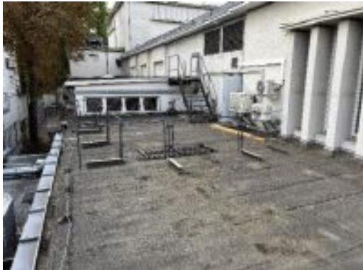
Flachdach mit Bitumenabdichtung
