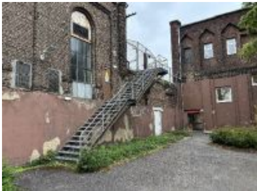
Außenanlage zwischen Gebäude 6 und 10
